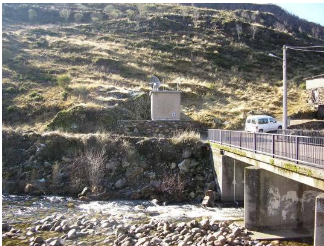
Figura 6: Estación de Nivel N009 en el río Bibey en Porto
